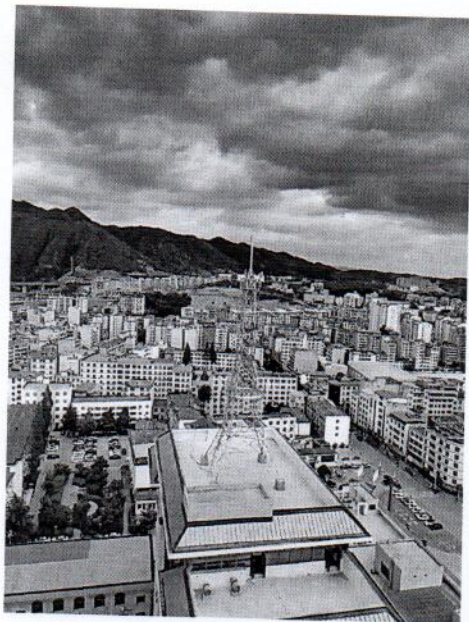
居民楼顶检测照片
