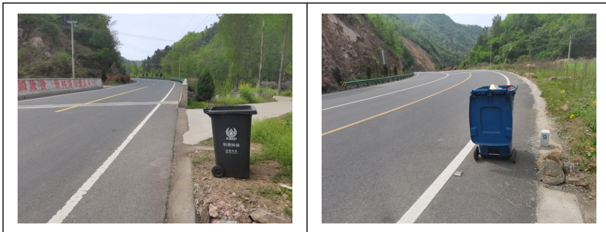
图 9.1-1 项目沿线垃圾收集设施
