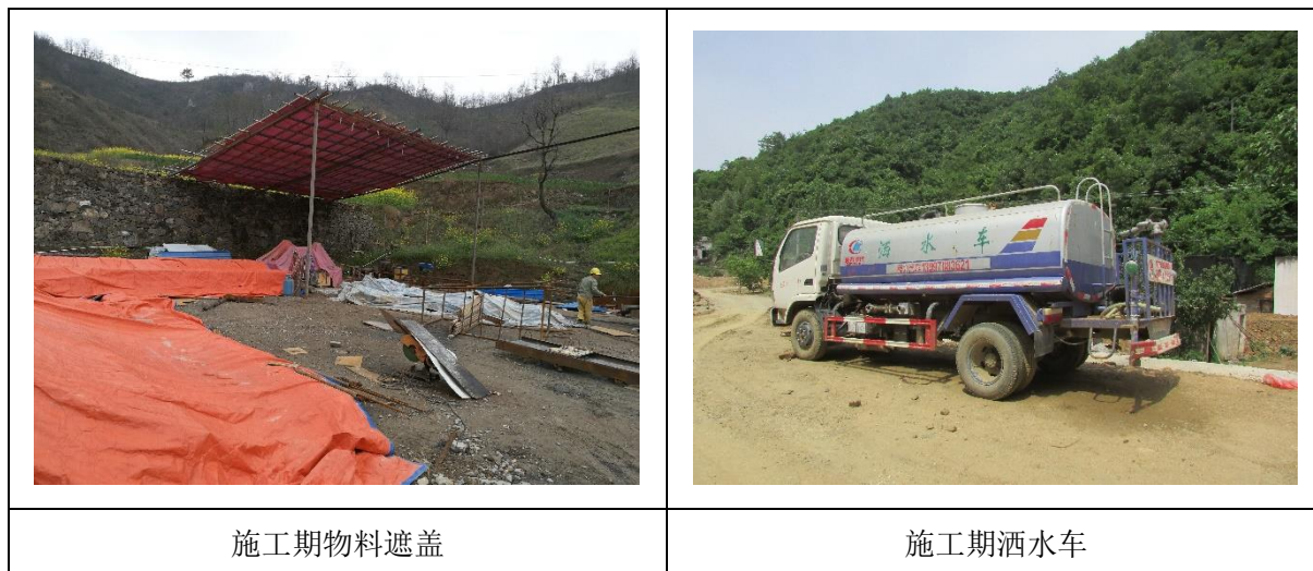
图 4.3-1 施工期大气污染防治措施图
