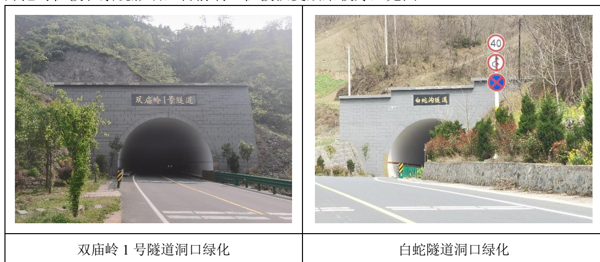
图 5.2-1 隧道洞口恢复现状
