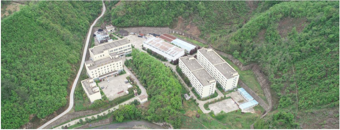
照片 2-11 生活区滑坡治理效果（镜像 90°）
