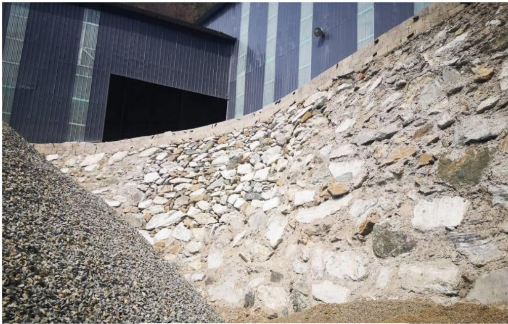
照片 2-6 加工区挡墙
