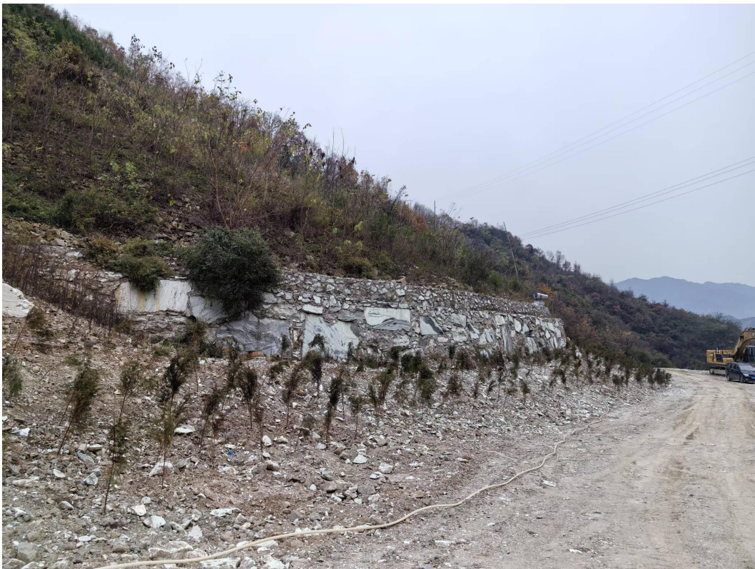
照片 2-8 办公室对面挡墙
