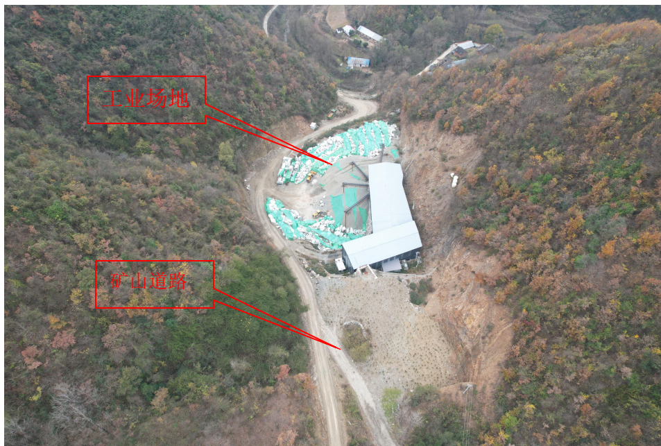
照片 3-4 工业场地及矿山道路
