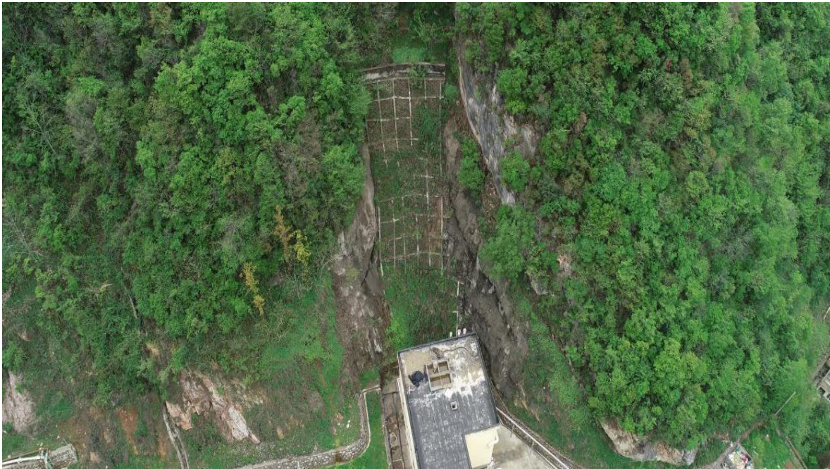
照片 2-12 锅炉房滑坡治理效果（镜像 150°）
