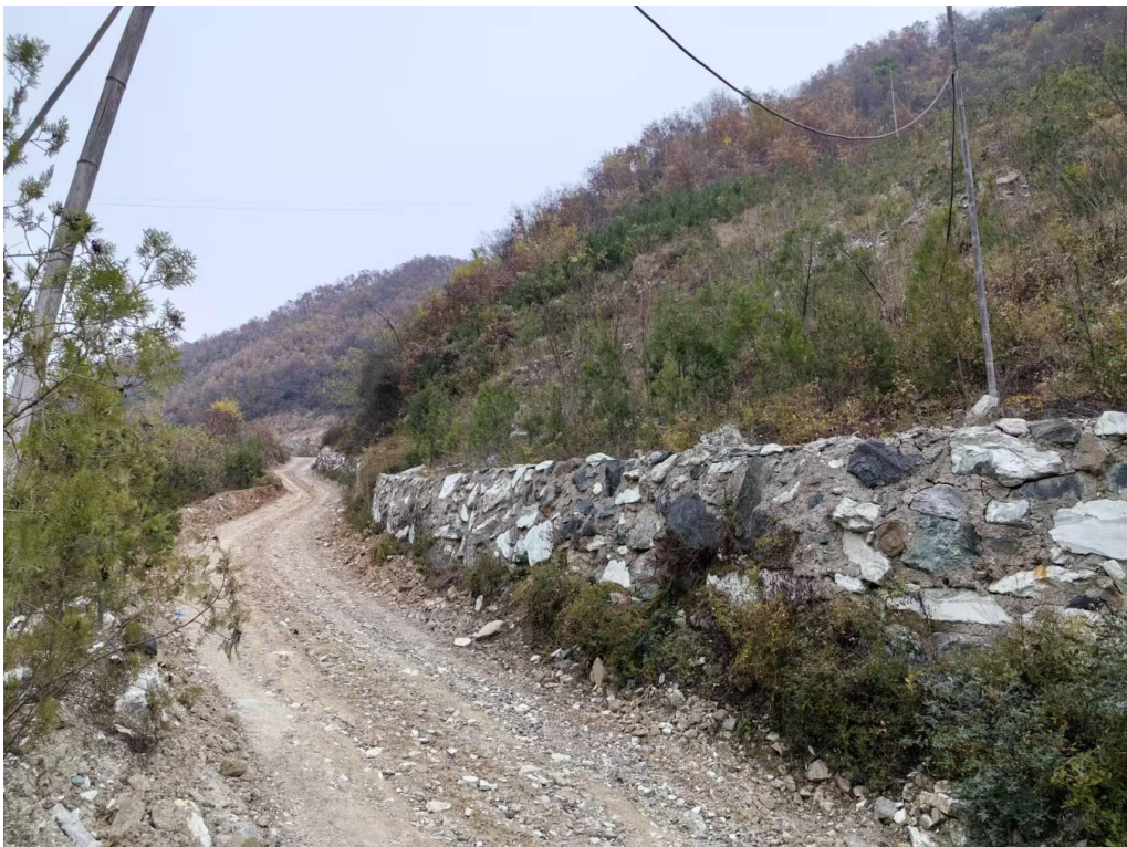
照片 2-10 渣堆挡墙及绿化
