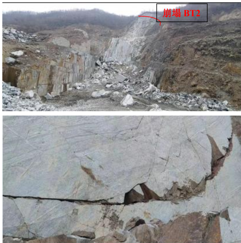
照片 3-2 BT2 崩塌全貌图（镜像 145°）
